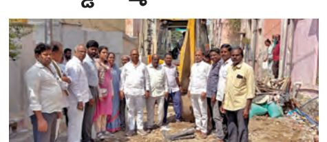
సీని రోడ్డు నిర్మాణ పనులను పరిశీలిస్తున్న కార్పొరేటర్ వెంకటేష్ గోడ్
